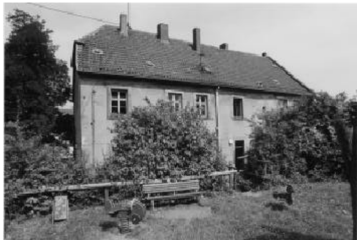
Rückseite des Schulgebäudes mit ehemaligem Schulgarten, Aufnahme Emanuel Roth, August 2001
