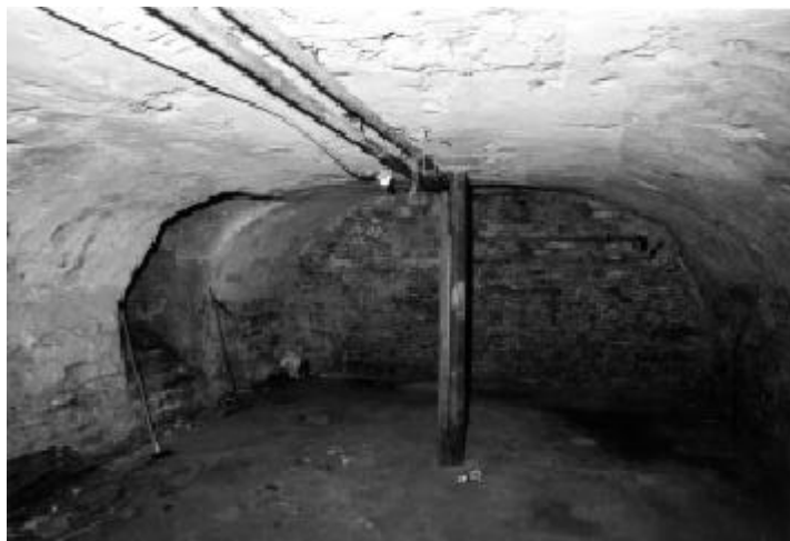
Barocker Keller der Schule mit Tonnenwölbung, Aufnahme Emanuel Roth, August 2001
